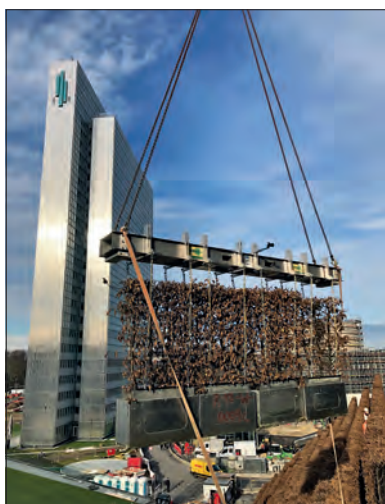
Angeliefert per Kran wurden die Heckengefäße eingebaut.
